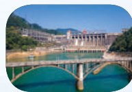
新安江水电站
